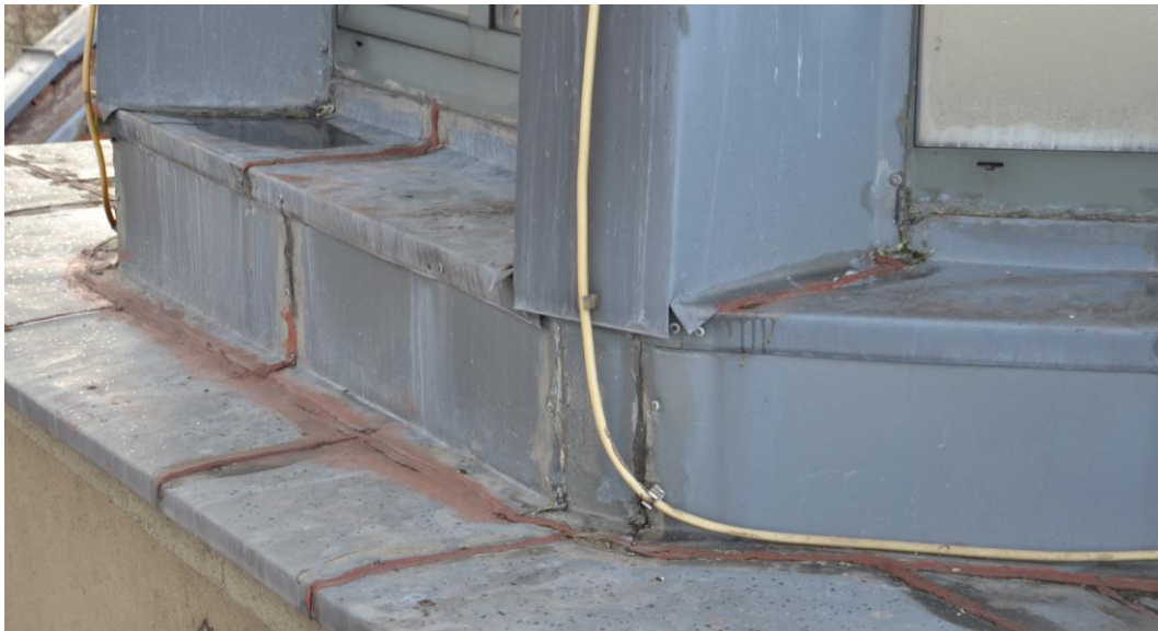
Foto. 46. Liczne uszczelnienia styków przy użyciu różnych materiałów, przeciwnie padki i zastoiny wody na obróbkach blacharskich [1.3].
