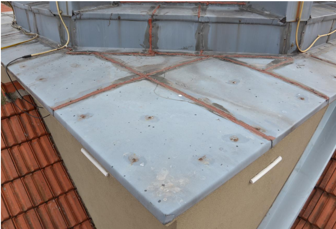
Foto. 60. Liczne uszczelnienia uszczelniaczem dekarskim; korozja łączników mechanicznych [1.3].
