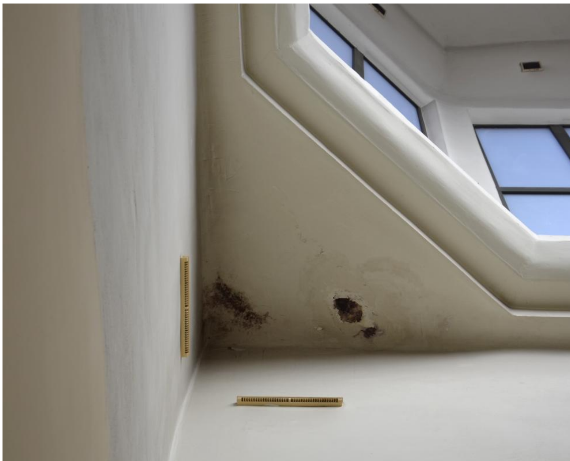
Foto. 56. Rozwój zagrzybienia, zacieki na gzymsie [1.3].
