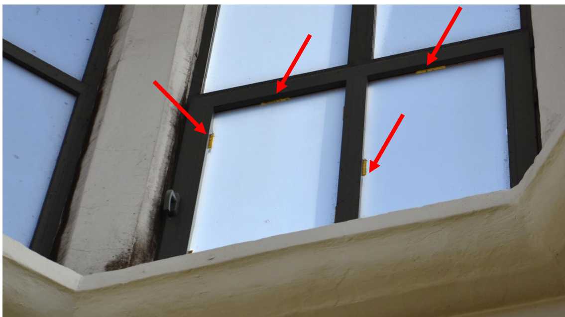
Foto. 10. Rozwój pleśni (zagrzybienia) na słupach oraz oknach; prowizoryczne uszczelnienia szyb (?) [1.3].
