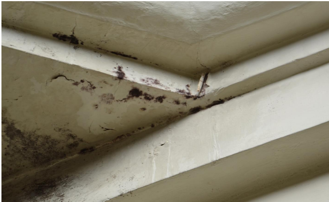
Foto. 15. Rozwój pleśni (zagrzybienia) na gzymsie; odspojenia farby i gładzi [1.3].
