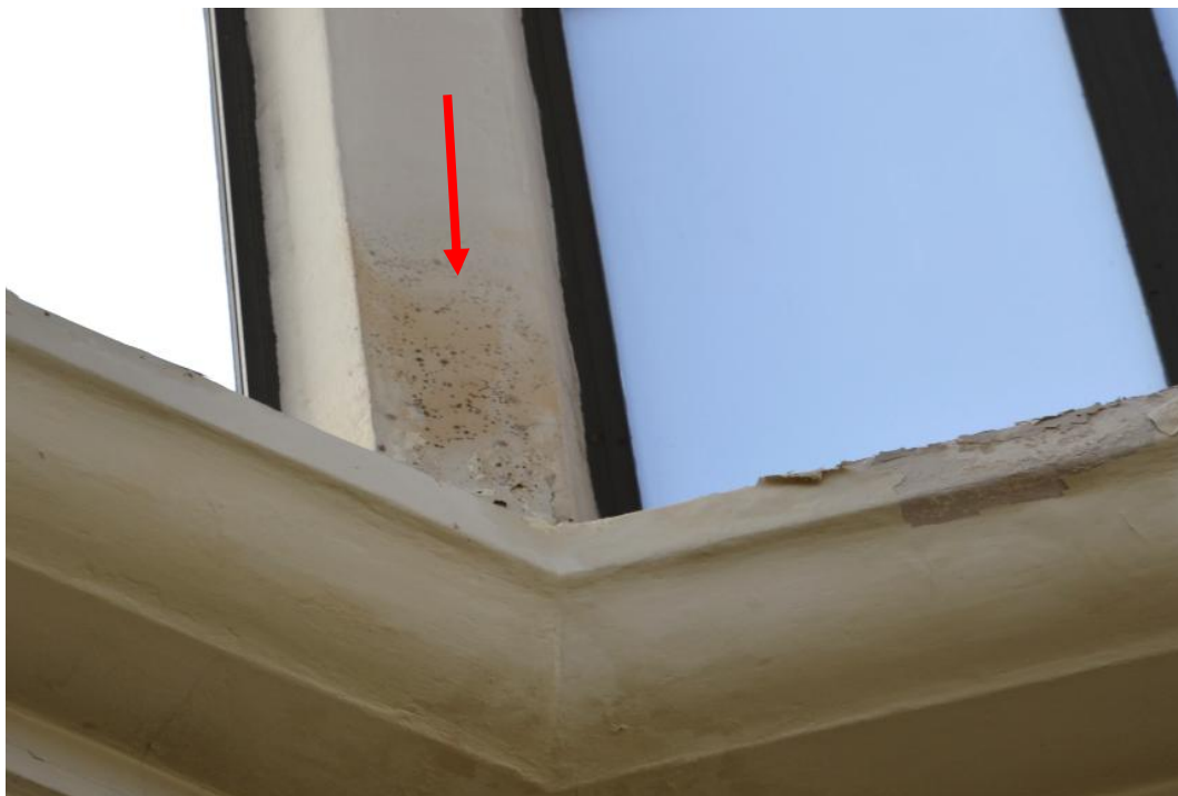
Foto. 42. Ślady zawilgocenia i zagrzybienia na filarku międzyokiennym [1.3].
