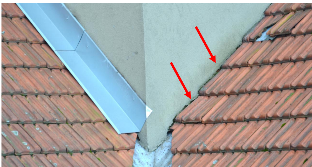
Foto. 45. Brak obróbki blacharskiej; odsłonięta dolna krawędź ocieplenia, uszkodzenie dachówki ceramicznej [1.3].
