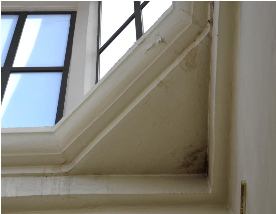
Foto. 21. Zagrzybienie, zacieki, odspojenia farby na dolnej powierzchni gzymsu [1.3].
