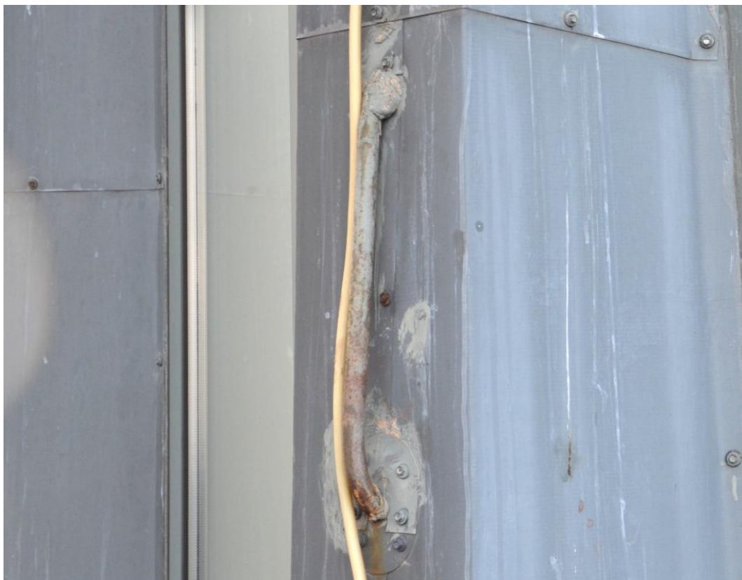
Foto. 52. Naloty korozyjne na uchwycie asekuracyjnym [1.3].
