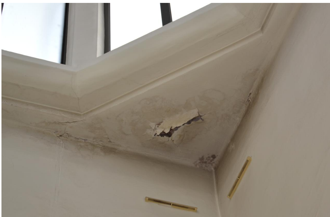
Foto. 55. Zacieki, odspojenia tynku, zarysowania na gzymsie [1.3].
