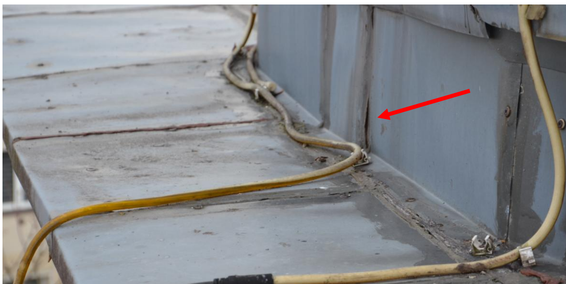
Foto. 69. Nieszczelności na stykach blachy [1.3].
