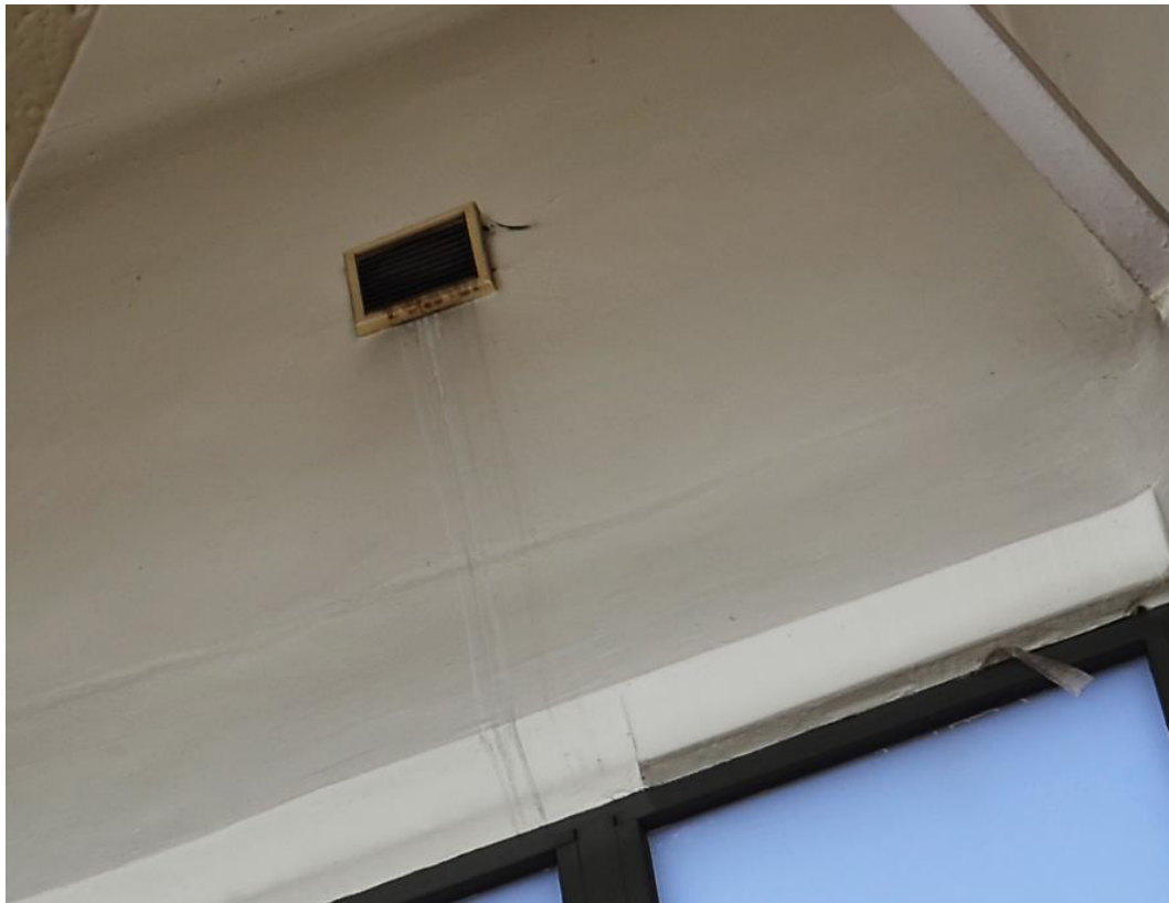
Foto. 32. Zacieki pod otworem wentylacyjnym [1.3].
