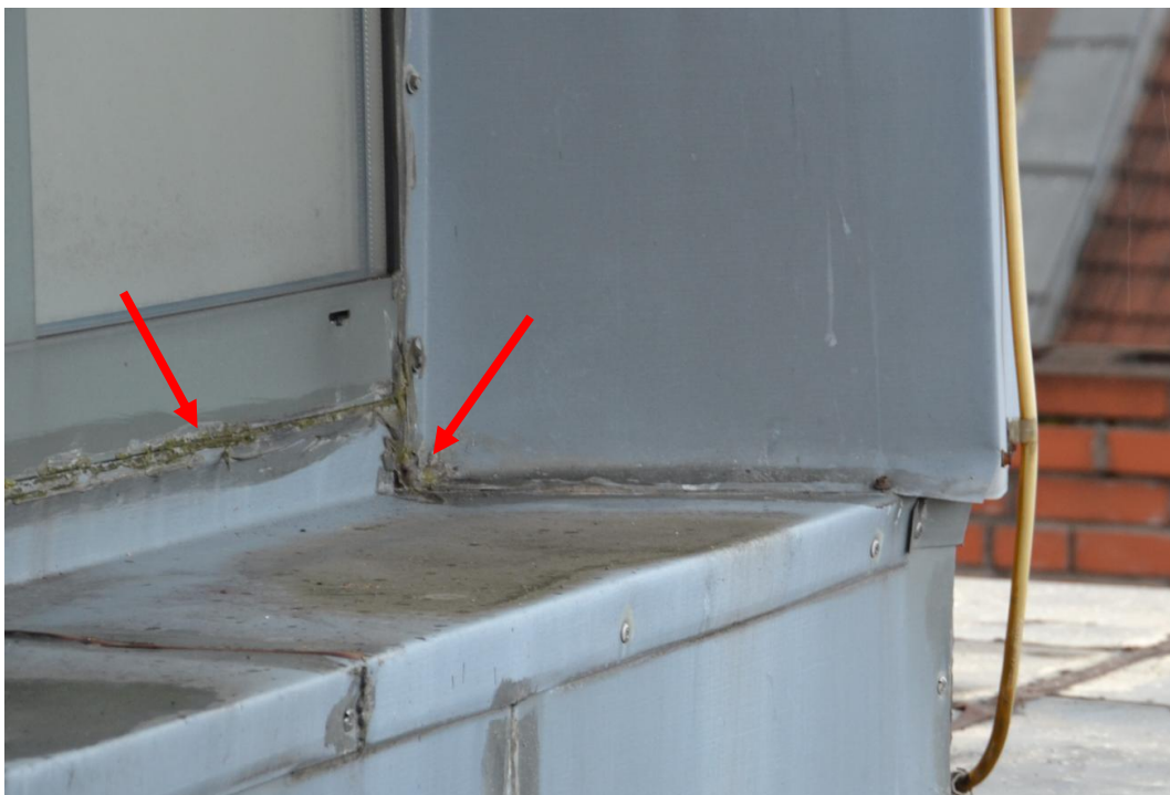
Foto. 49. Rozwój glonów na powierzchni wykonanych uszczelnień [1.3].
