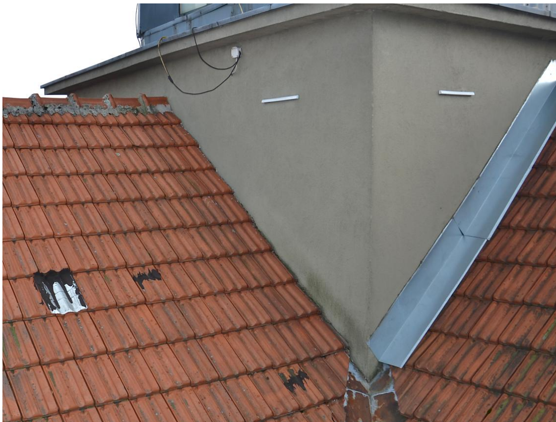
Foto. 70. Brak wyprowadzonej obróbki blacharskiej; rozwój glonów na ocieplonej części ściany wieżyczki, uszkodzenia dachówki ceramicznej [1.3].
