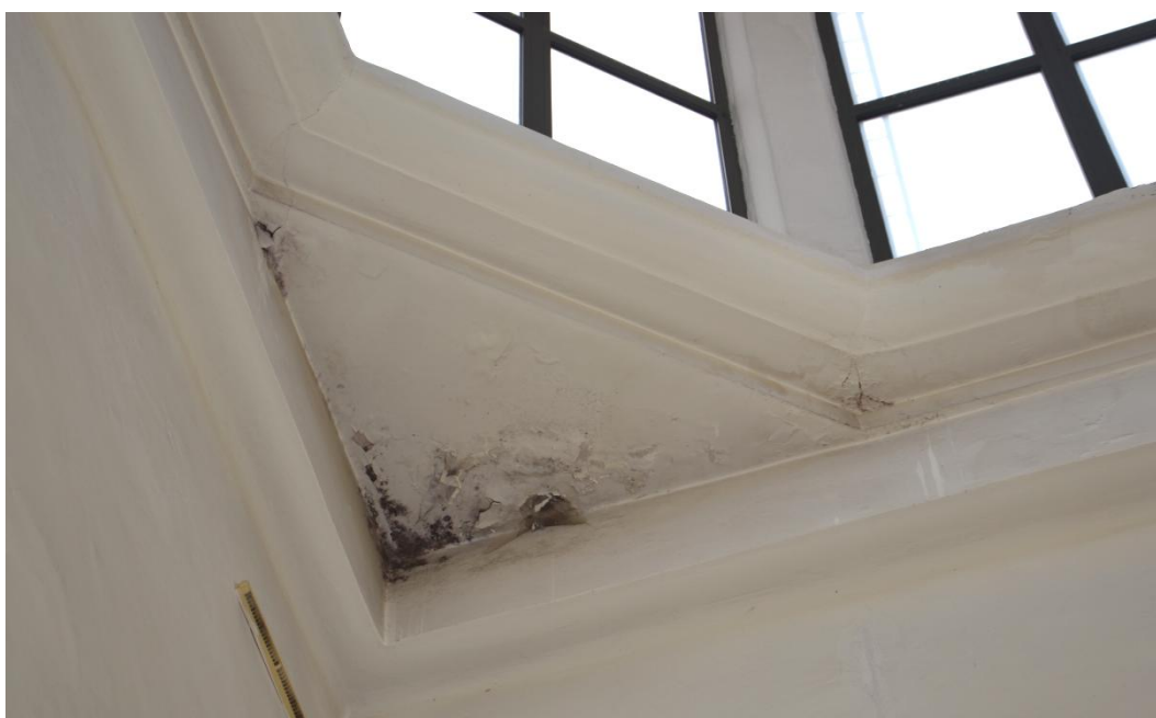
Foto. 37. Rozwój pleśni na spodzie gzymsu; odspojenia tynku i farby [1.3].
