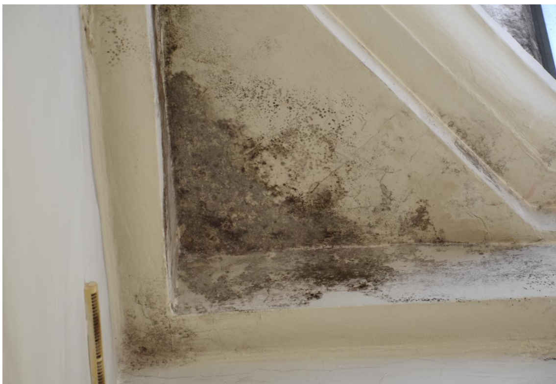
Foto. 12. Rozwój pleśni (zagrzybienia) na gzymsie; zarysowania gzymsu [1.3].
