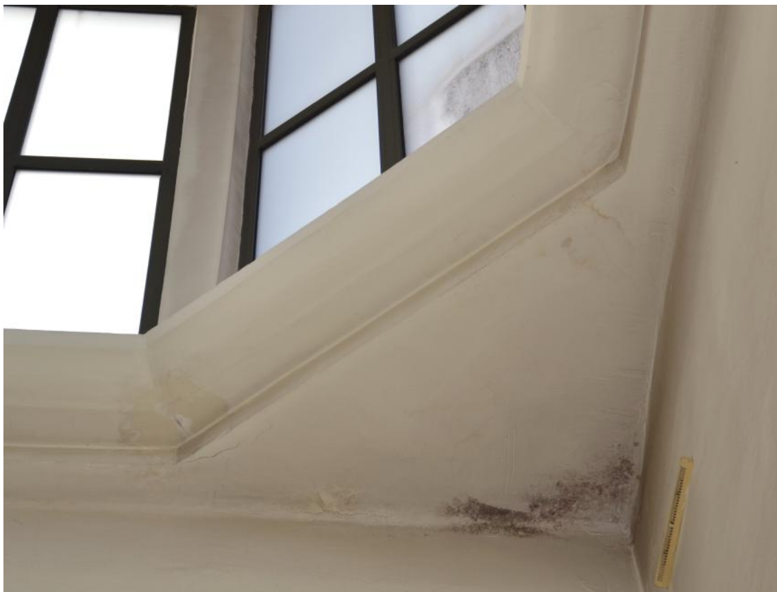
Foto. 57. Rozwój zagrzybienia, zacieki na gzymsie [1.3].
