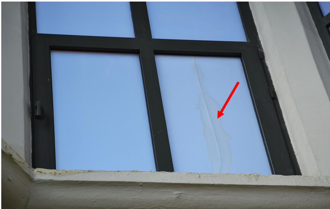
Foto. 22. Pęknięta szyba w skrzydle okna otwieranego [1.3].
