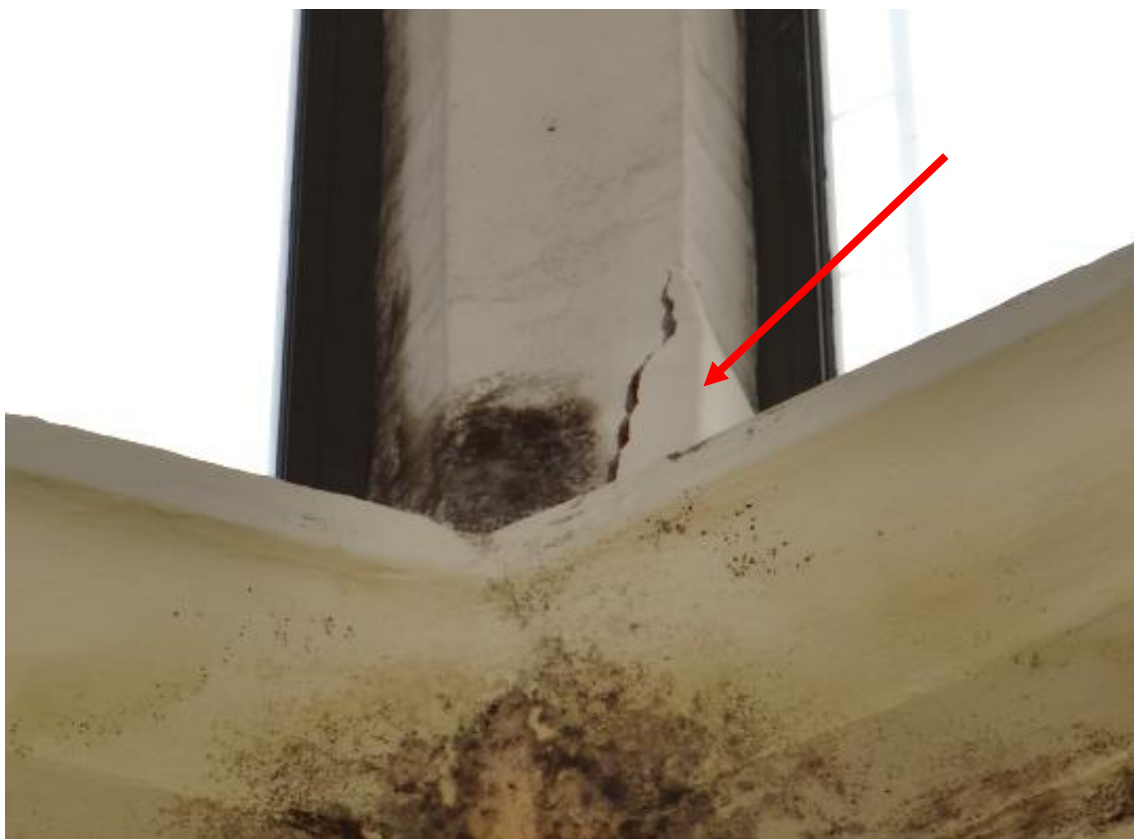
Foto. 7. Odspojenie otuliny na jednym ze słupów [1.3].
