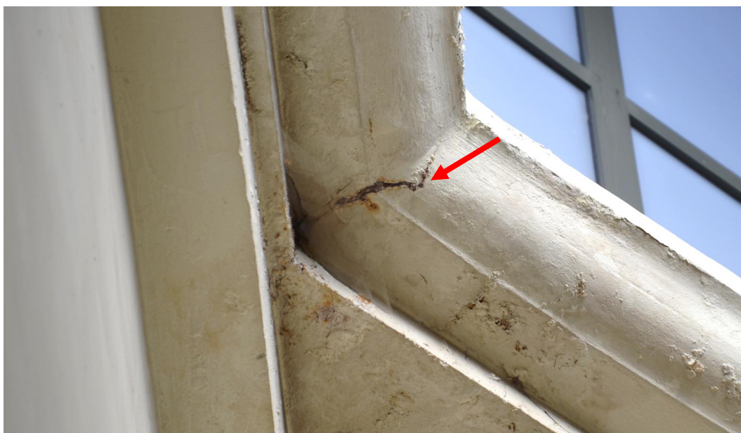
Foto. 30. Nalot korozyjny w spękaniu gzymsu [1.3].
