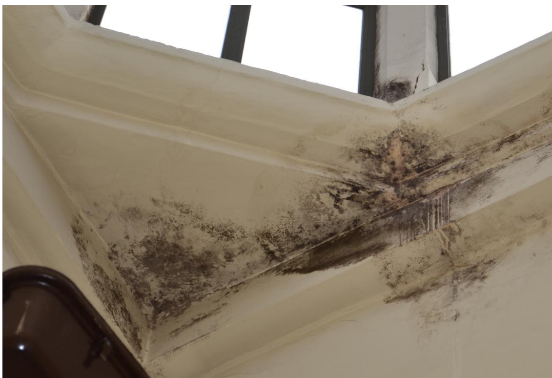
Foto. 6. Zagrzybienie, zacieki, zabrudzenia na dolnej powierzchni gzymsu [1.3].
