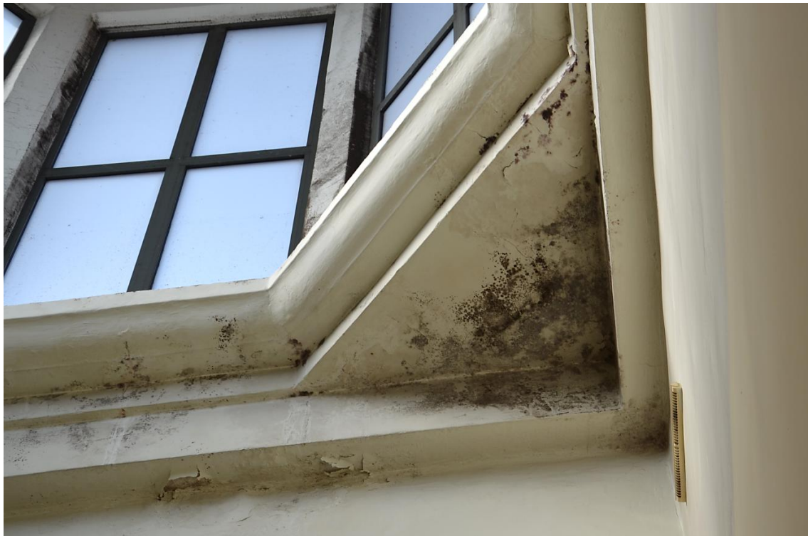
Foto. 11. Rozwój pleśni (zagrzybienia) na gzymsie; odspojenia farby i gładzi [1.3].
