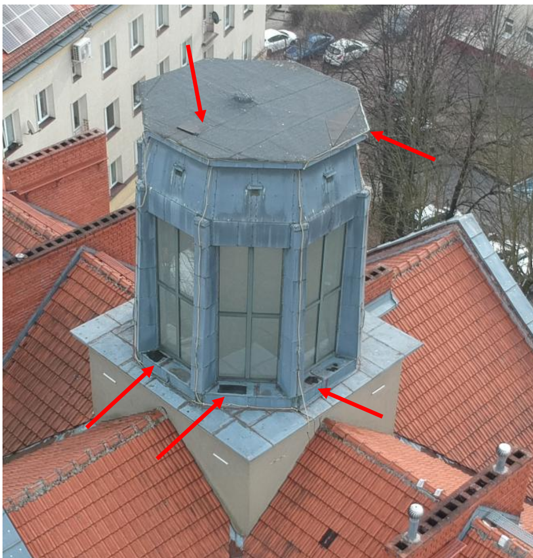
Foto. 44. Zerwane fragmenty papy; zastoiny wody na parapetach [1.3].
