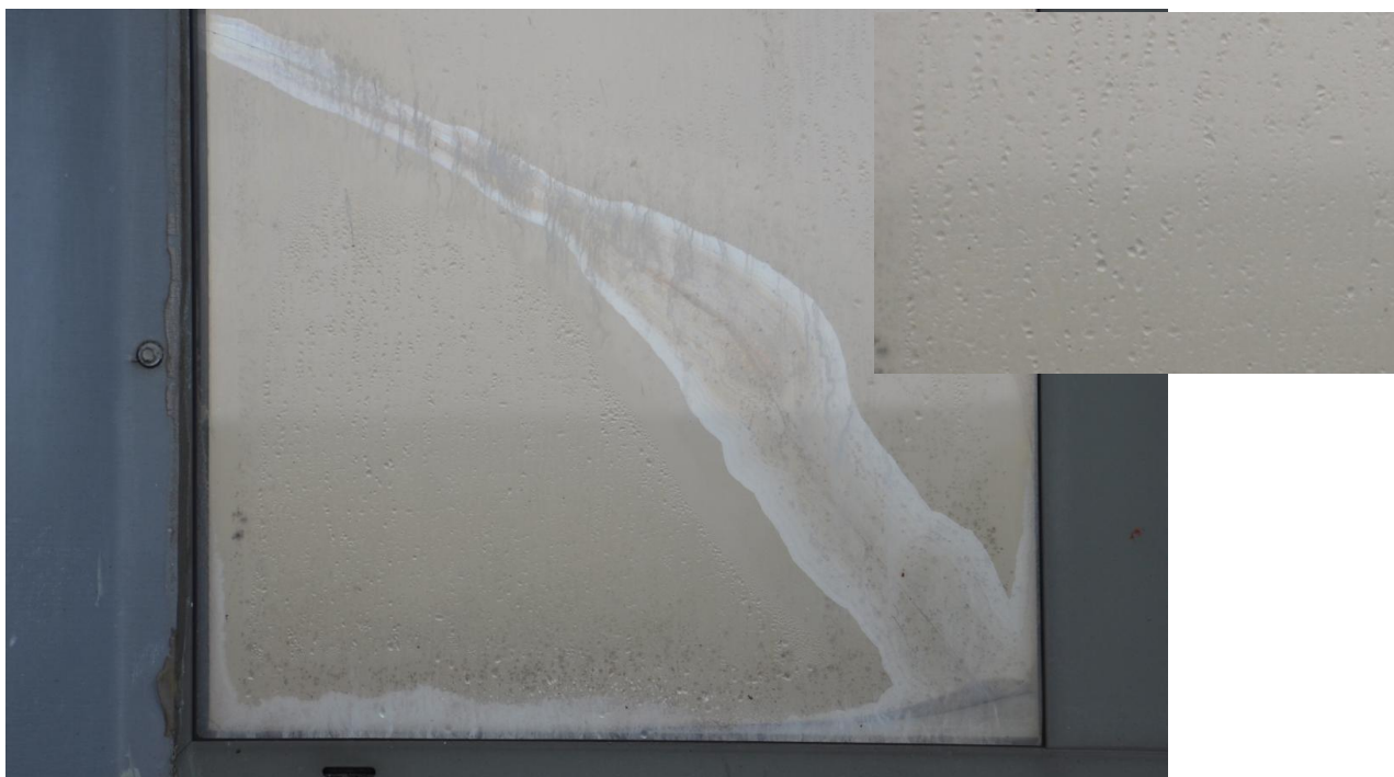
Foto. 53. Pęknięta szyba; widoczne skropliny we wkładzie szybowym [1.3].
