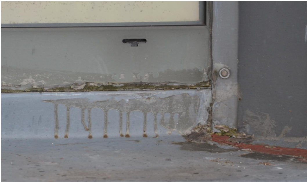
Foto. 50. Rozwój glonów na powierzchni wykonanych uszczelnień; zabrudzenia i zacieki powstałe w wyniku nakładania mas uszczelniających [1.3].
